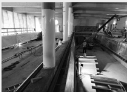
Koncem března byl odstraněn stavební jeřáb a intenzivní práce pokračují v interiéru. Foto: D. Palátková
