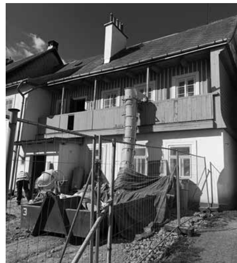
Rekonstrukční práce domu čp. 210.
